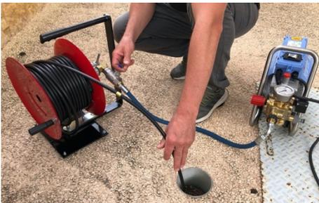
Flexible de canalisation de 15 à 50 mètres suivants le diamètre
